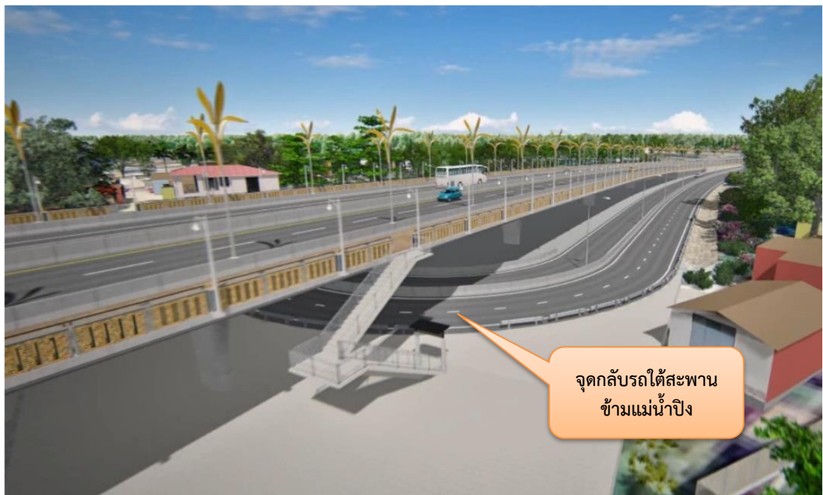
รูปที่ 2.2.1-7 รูปแบบถนนคู่ขนานสะพานข้ามแม่น้ำปิง และจุดกลับรถได้สะพานข้ามแม่น้ำปิง
